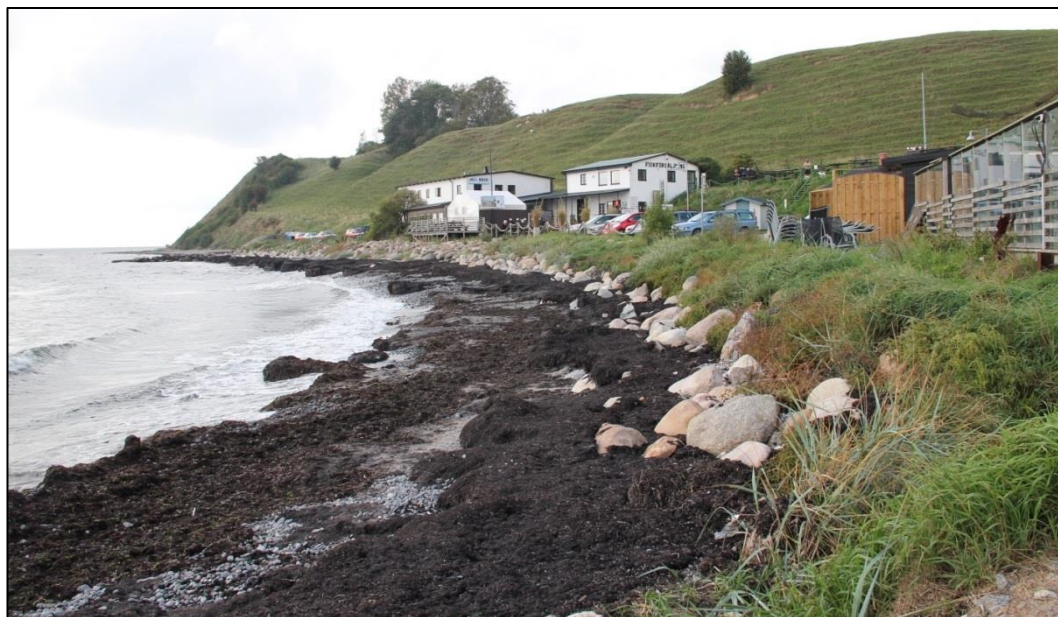
Figur 7-27 Halvt raserad stenskonig väster om hamnen.
