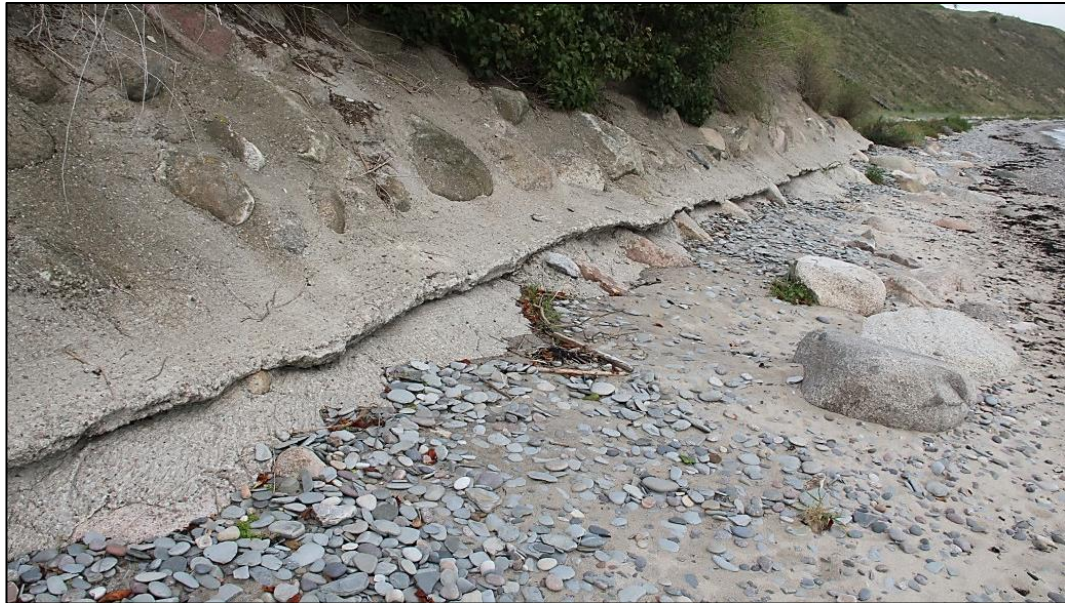
Figur 7-29 Skoningen är tydligt lagad i underkanten, vilket tyder på att strandplanet var högre när skoningen anlades.
