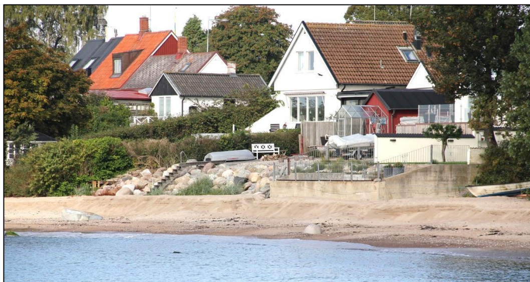
Figur 7-3 Bebyggelsen väster om badbryggan. Tydlig erosionskant och fastigheterna skyddas av sten och betong. Vattenbrynet är mycket nära fasthetsgränserna.
