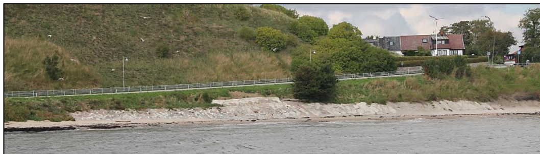
Figur 7-28 Sten/betongskoning som skyddar slänten utmed vägen ner till hamnen i Kåseberga.
