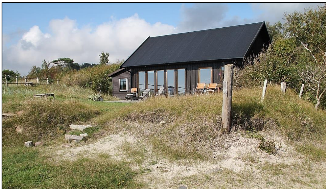
Figur 7-36 Nybyggt med tydliga spår av erosion i tomtgränsen trots stenskoningar nedanför (syns ej i bild). Huset har ersatt ett äldre hus på samma yta.
